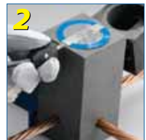
2 Enchufe el clip de conexión de la unidad de encendido a la tira de ignición
